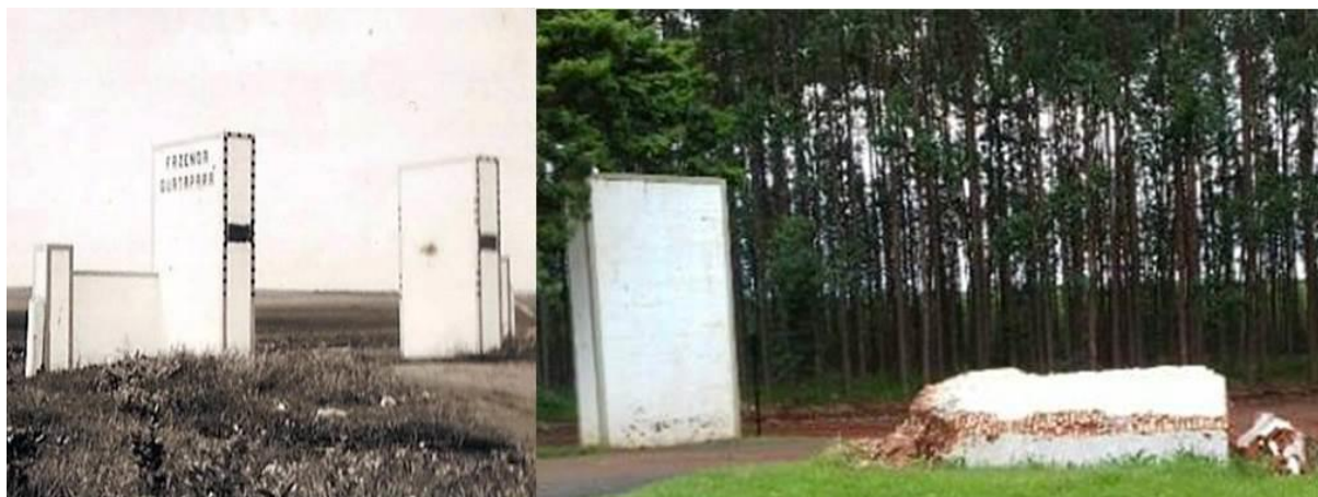
Figura 3. Portal nos anos 60 e sua demolição em novembro de 2017.
