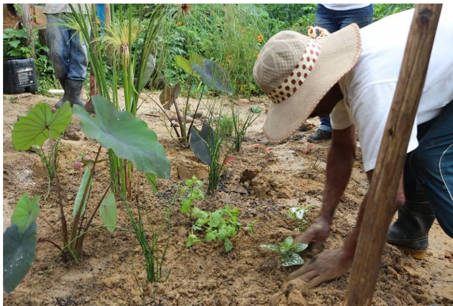
Figura 10 - Plantio das mudas do jardim filtrante.
