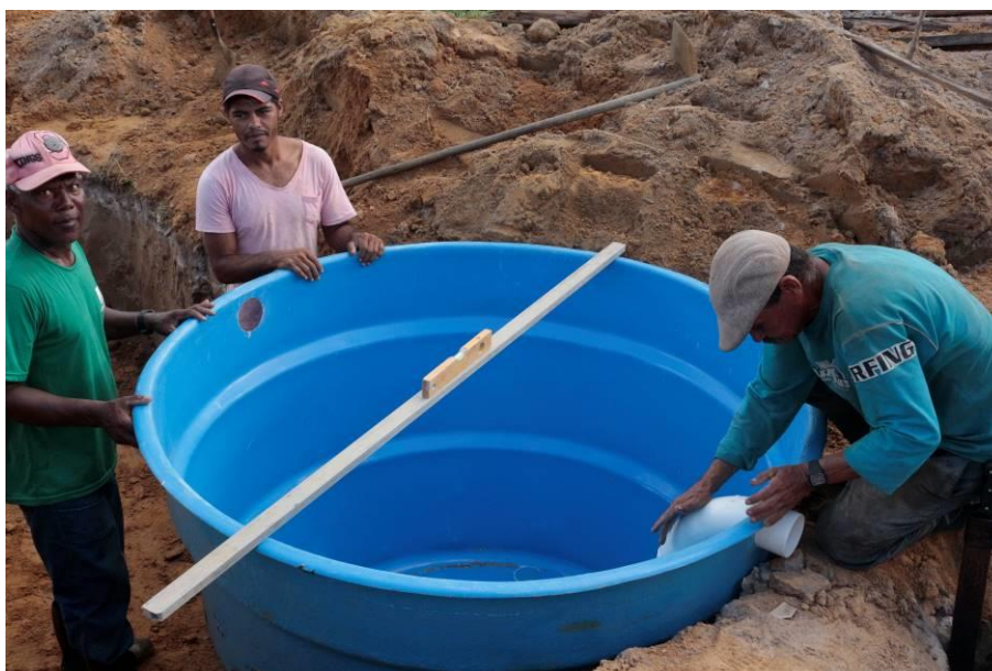
Figura 4 – Nivelamento das caixas. Início da montagem da fossa séptica biodigestora.
