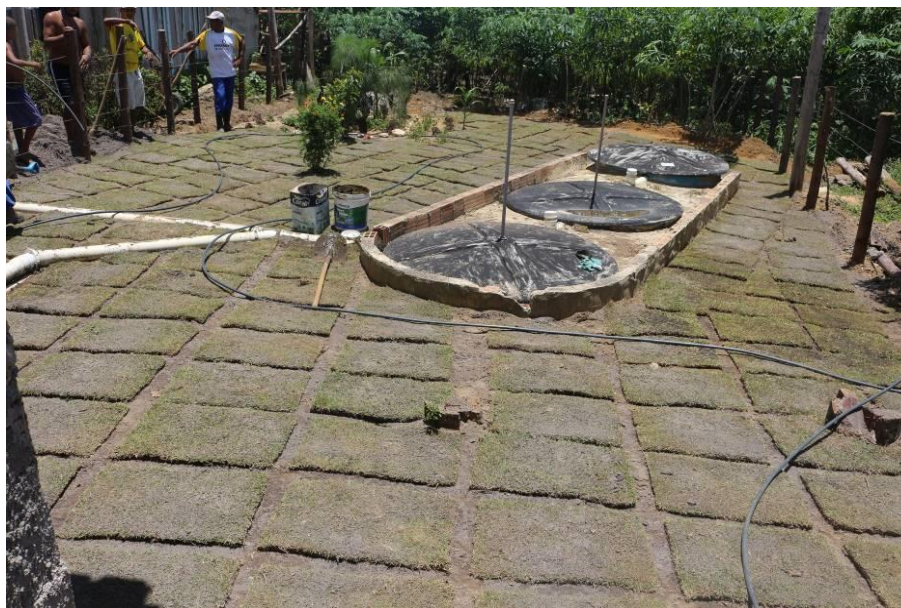
Figura 12 - Plantio da grama esmeralda na área total do sistema.
