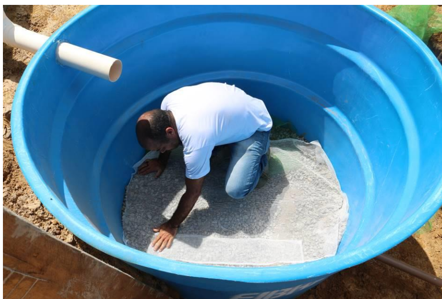
Figura 6 – Preparo do filtro na última caixa. Duas camadas de brita separadas por uma tela e uma camada de areia ao final.
