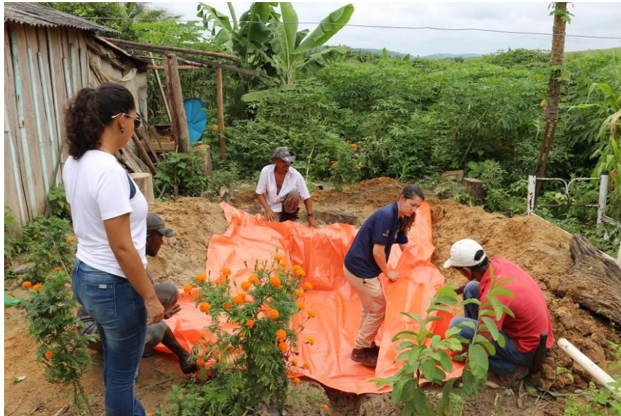
Figura 8 – Implantação do jardim filtrante.
