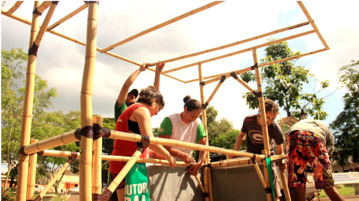
Figura 4: Armação da estrutura do estande.
