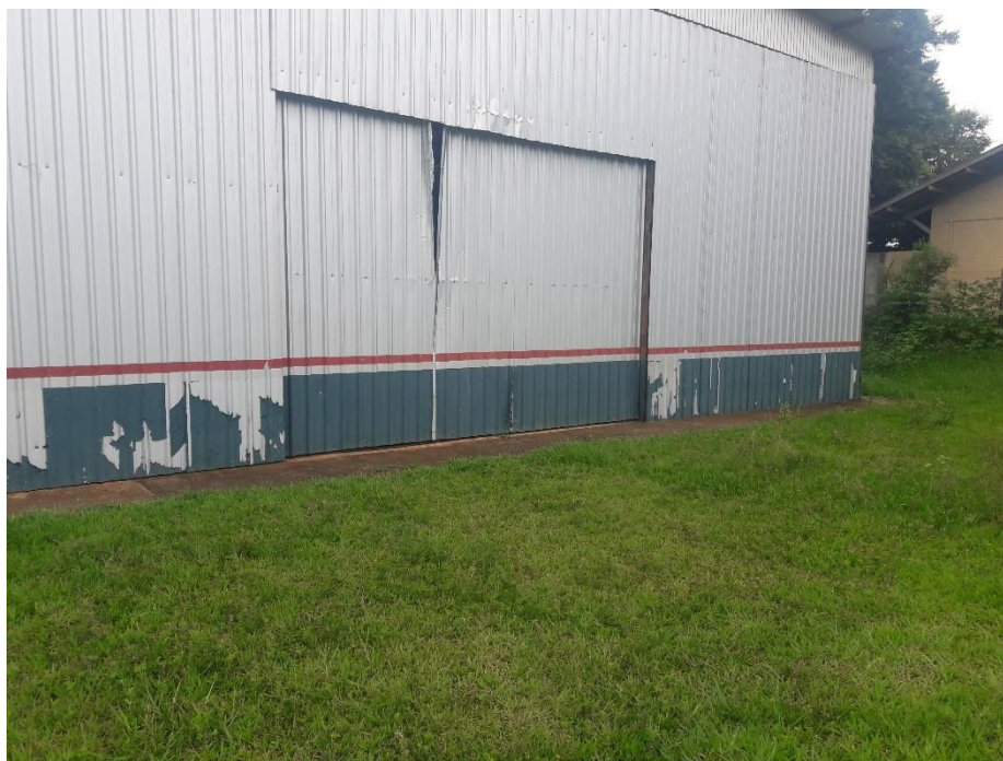
Figura 3 - Entrada do Galpão. Fonte: Arquivo pessoal dos autores
