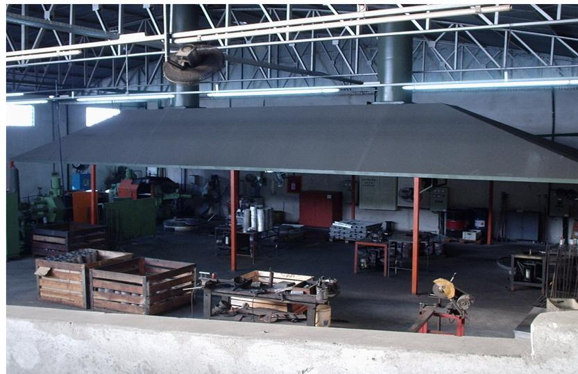
**Figura 4.14 – Sistema de coifa e exaustão do setor de solda e fundição, após a reestruturação**
