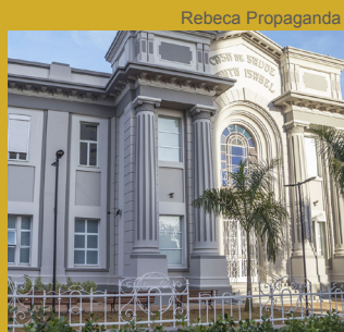
Fachada foi modernizada
