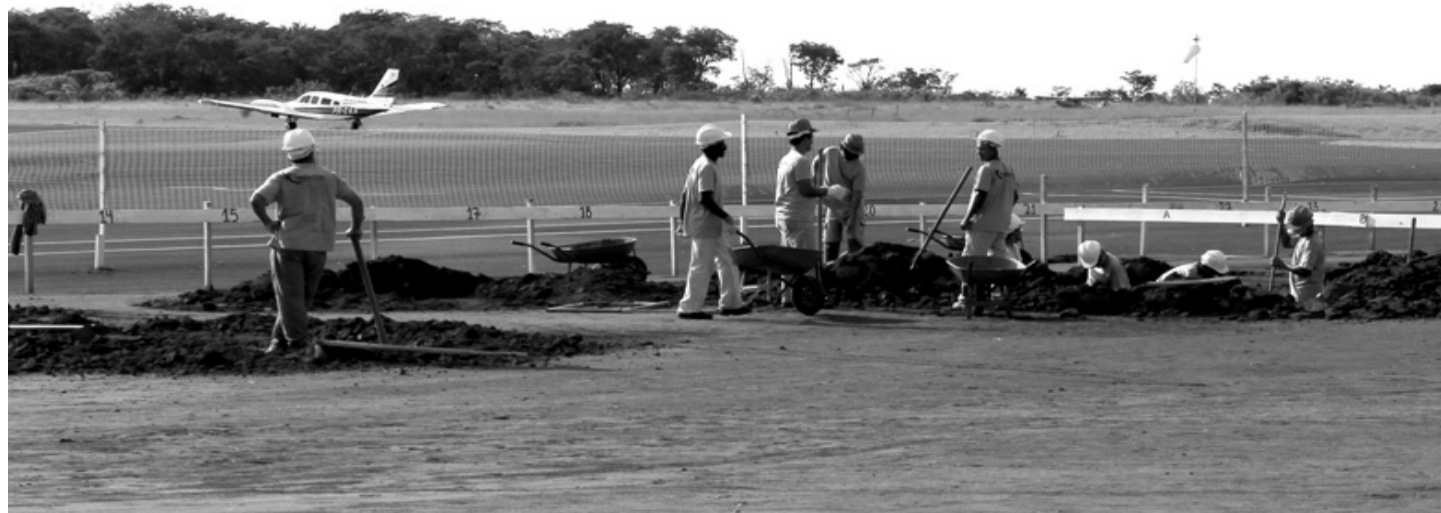
Funcionários trabalhando na obra do novo terminal aeroportuário de Araraquara
