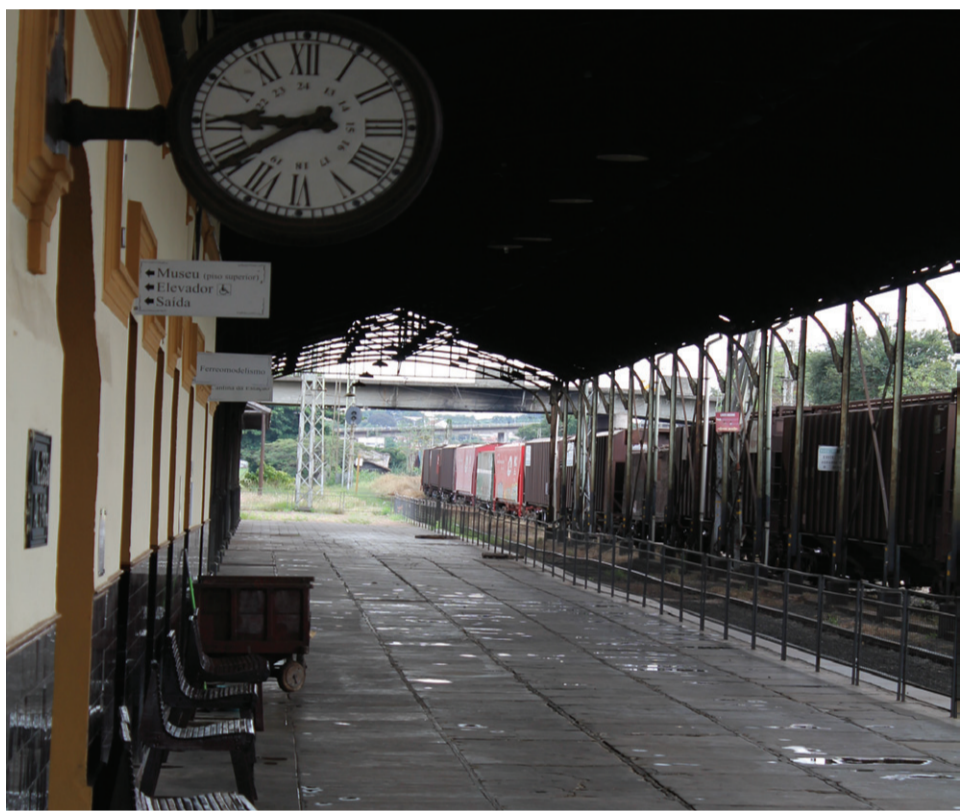
Estação Férrea e Museu Ferroviário de Araraquara
