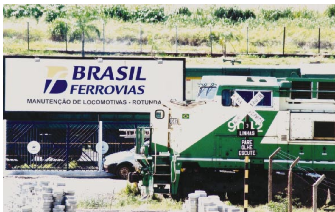
Urbanização da Ferrovia fará integração do centro com a Vila Xavier
