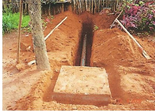
Figura 2. Detalhe da construção de uma caixa de passagem, caixa pronta e coletor assentado na vala. Fonte: Santiago (2008).
