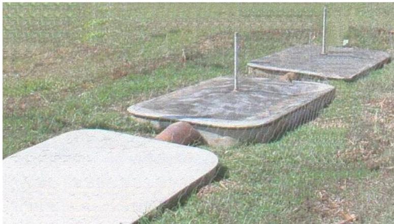
Figura 7. Vista do sistema de fossas e filtro de fibrocimento já implantado.
