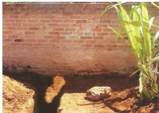
Figura 1. Abertura manual de vala para coletor simplificado e vala pronta. Fonte: Santiago (2008).
