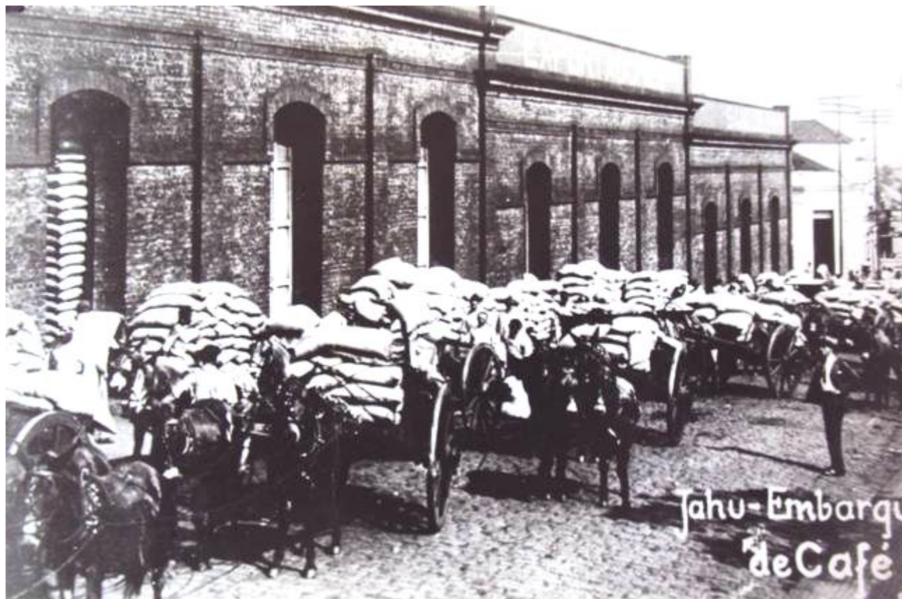
Figura 23 - Armazém localizado na Rua Humaitá que pertenceu à Casa Comissária Almeida Prado & Exportadora - Posteriormente doado à Associação São Vicente de Paula para geração de rendimento para a entidade assistencialista , sem data. Fonte: Arquivo Municipal de Jahu
