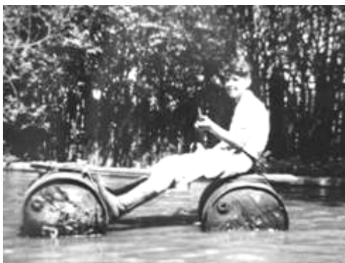
Figura 72 - Francisco Pio de Almeida Prado Filho no reservatório de água, 1952. Fonte: Acervo Família Almeida Prado
