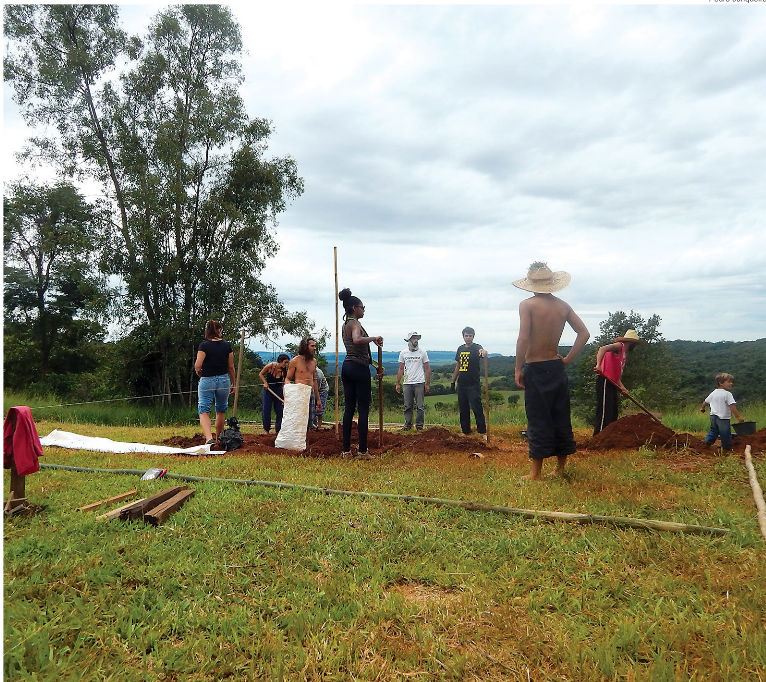
Moradores trabalham na bioconstrução de um Chalé Yurt, moradia feita com bambu e barro
