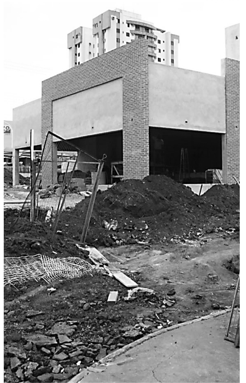
Obras do prédio da famosa lanchonete em Jaboticabal
